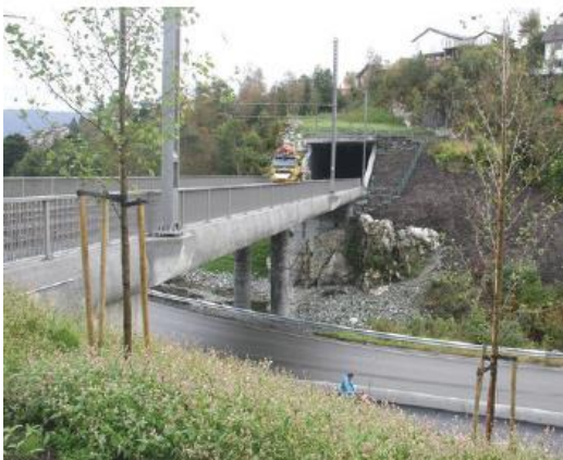
Figur 30: KL-master over bru, fra Prosjekteringsveilederen for Bybanen.
